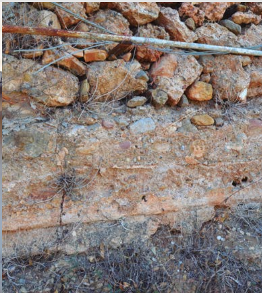
Imatge 3: Un tros de la conducció sobre la que s'ha situat un ribàs.
