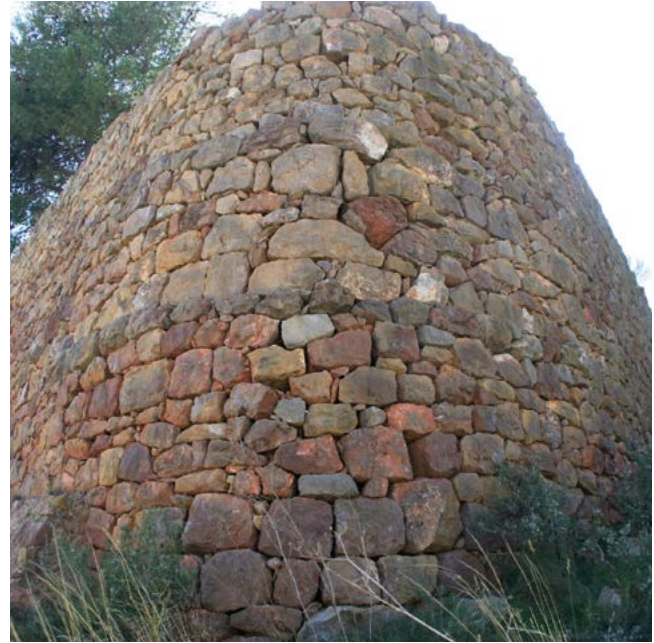
Cantonada de pedra seca, realitzada a principis segle XX, per Pepet de Floquencio (Josep Falomir Vicent), als Fornets (forns de cement blanc de Luis Monterde).
