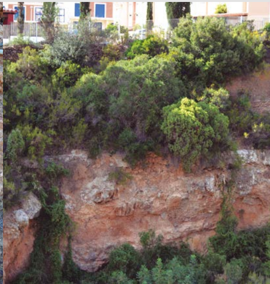
Imatge 4: En la paret vertical del barranc de Cominells s'aprecien les construccions, presumiblement, per a la conducció de l'aigua.
