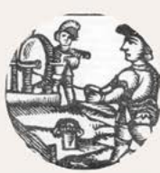
Afermentament per aprendre l'ofici d'encordemur 14 SETEMBRE DE 2017
