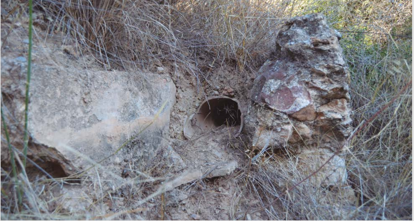
Imatge 6: Imatge de la conducció on es veu la sèquia i un dels tubs ceràmics.
