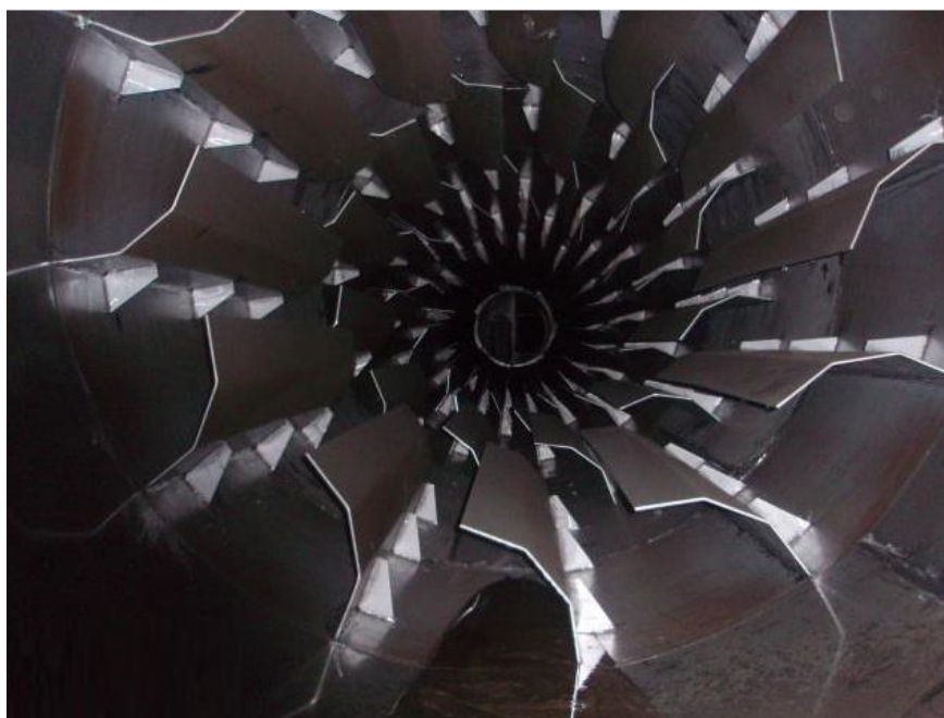
Imagen 11: Vista interior del deshidratador de sulfato amónico.
