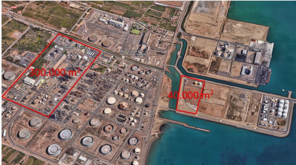
Imagen 3: Vista aérea de la superficie de la planta.
