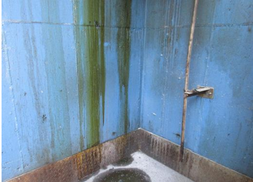
Imagen 29: Lubricante acumulado en los alrededores del equipo.
