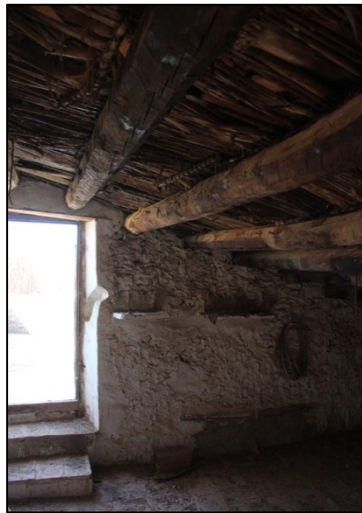
Imagen 30. Interior de cubierta inclinada.
