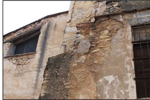
Imagen 42. Revestimiento en fachada calle San Joaquin.
