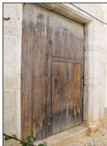
Imagen 41. Puerta principal. Calle San Joaquín.
