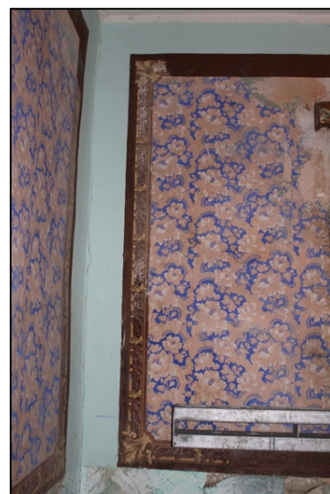
Imagen 44. Revestimiento interior, sala 10 de planta baja.
