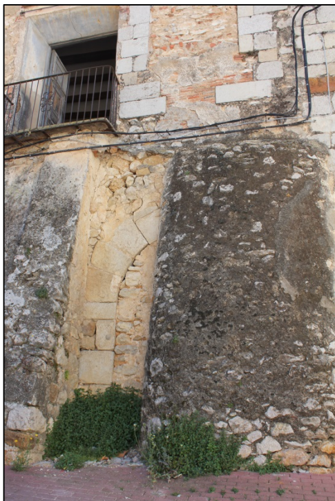
Imagen 29. Arco de fachada tapiado en la calle l'Hospital.
