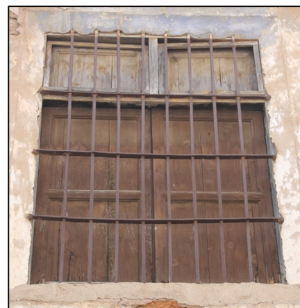
Imagen 33. Ventana de cocina, fachada calle San Joaquim.
