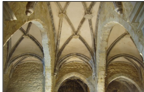
Imagen 7. Interior de la Iglesia Antigua. www.rutasjaumei.com
