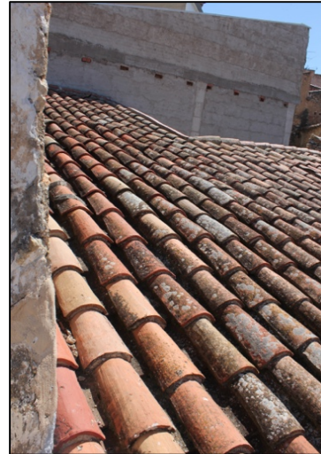
Imagen 31. Exterior de cubierta inclinada.
