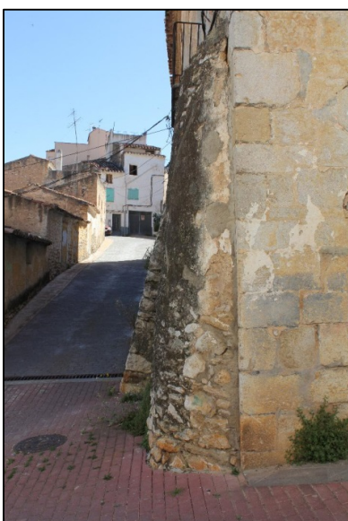
Imágenes 35 y 36. Contrafuertes de la calle L'Hospital.
