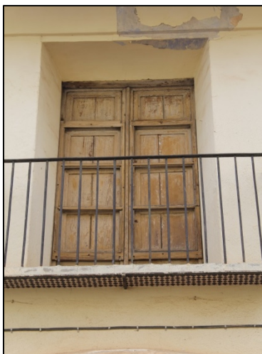
Imagen 40. Carpintería en balcón. Fachada San Joaquín
