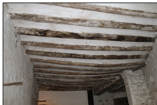
Imagen 65. Forjado planta baja. Sala 1.
