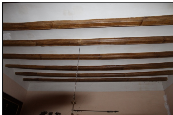
Imagen 67. Forjado planta baja, sala 9.
