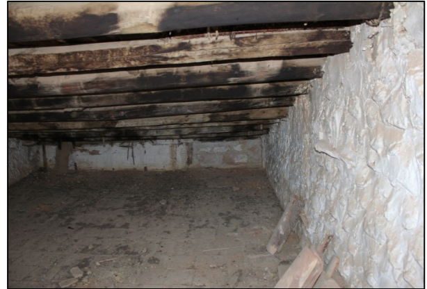
Imagen 26. Forjado de estancia en la cubierta. Cañizo y yeso
