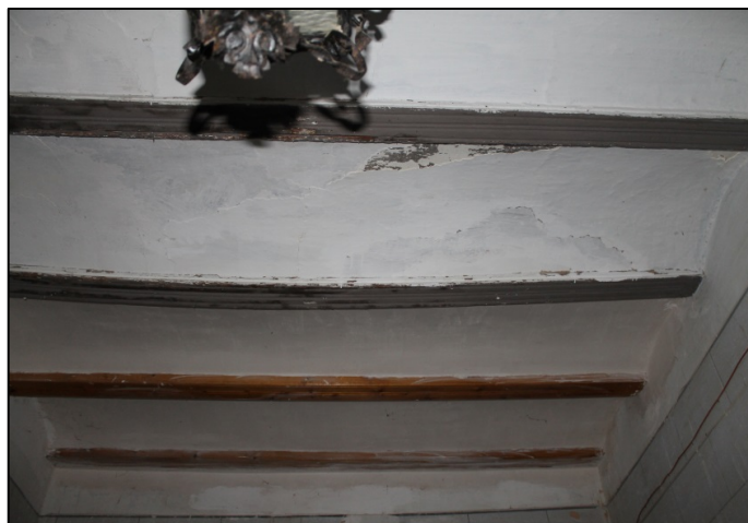
Imagen 27. Forjado de estancia en Planta Baja. Entrevigado con roscas de ladrillo.
