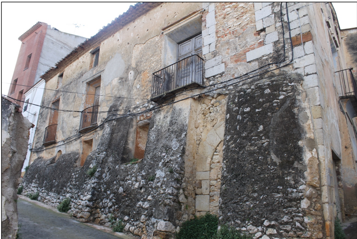
Imagen 22. Fachada calle L'Hospital.
