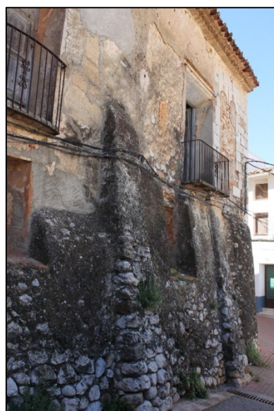
Imágenes 35 y 36. Contrafuertes de la calle L'Hospital.
