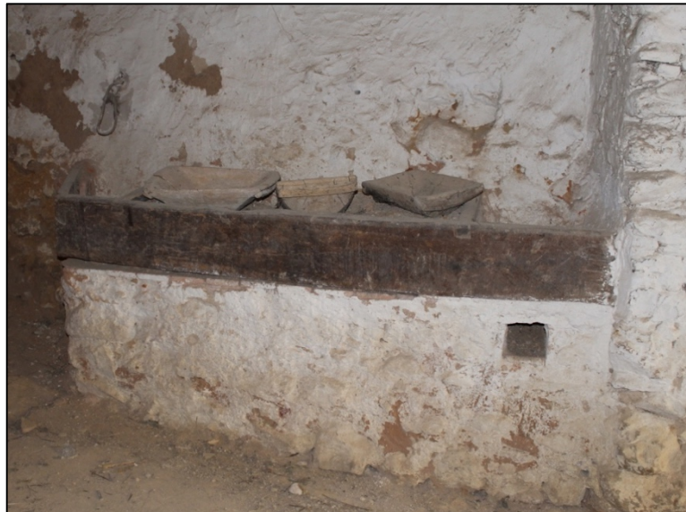
Imagen 23. Muro de mampostería
