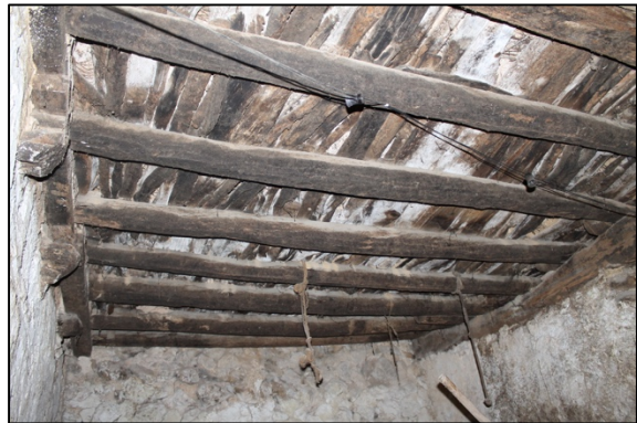
Imagen 66. Forjado sótano sala 10.
