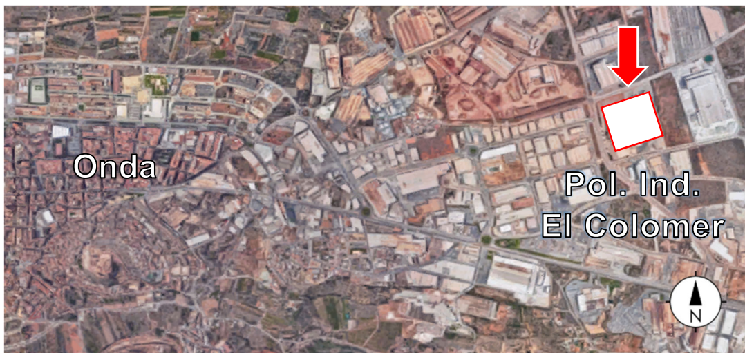
Figura 2. Vista área del Polígono industrial El Colomer. Fuente: Google Maps
