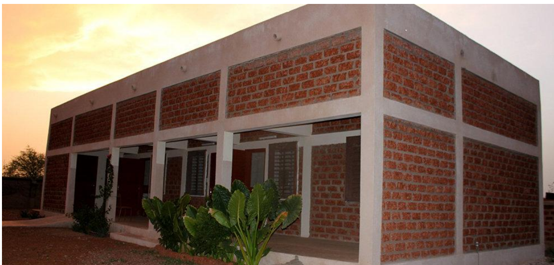
Ilustración 6- Hospital de Safané
