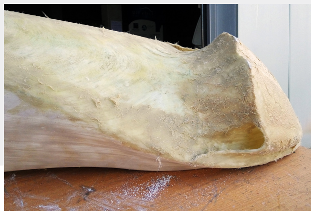
Fig. 117 Detalle de la segunda capa de masilla de FV en el colín
