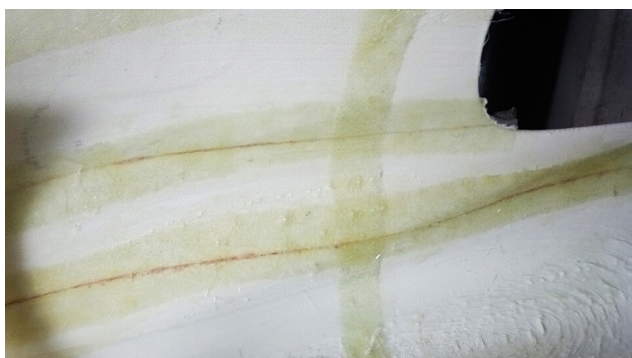
Fig. 112 Detalle de unión de piezas en el interior de la quilla
