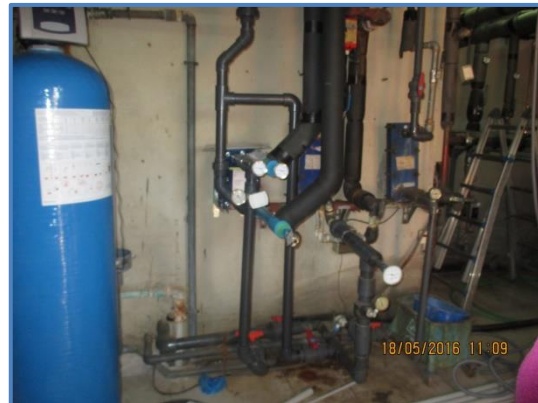
Imagen del intercambiador del circuito del vaso pequeño. Vista de los intercambiadores de la instalación.
