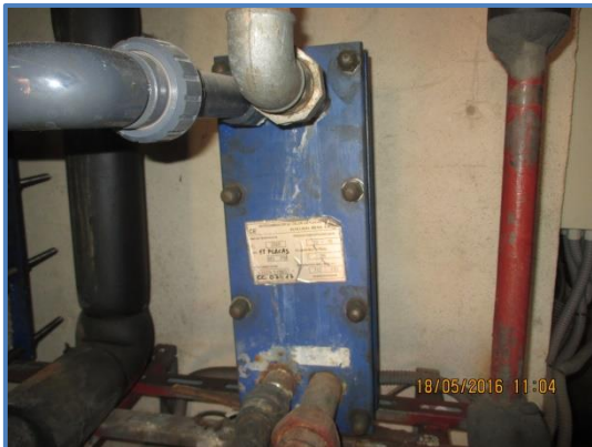
Imagen del intercambiador del circuito del vaso pequeño. Vista de los intercambiadores de la instalación.
