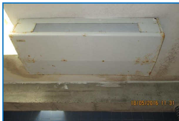
Imagen del modelo de termoventilador existente en los vestuarios.
