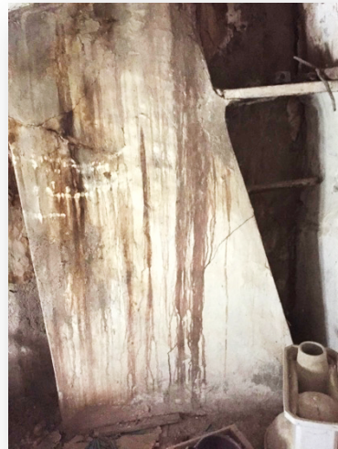
Tiro de la chimenea en planta buhardilla
