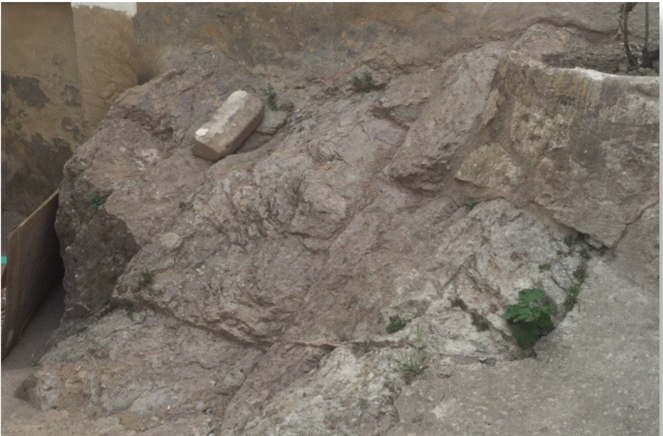
Parte de la montaña que se adentra en la vivienda en la planta sótano
