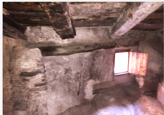
Viga transversal de fachada desde el interior
