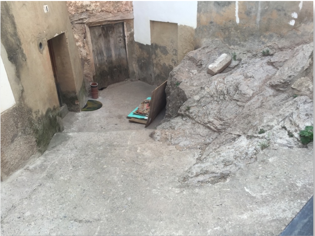
Calle molino. Zona que se destinará a apeos
