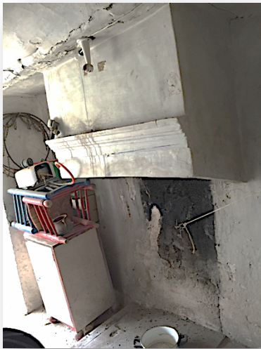
Chimenea en planta baja
