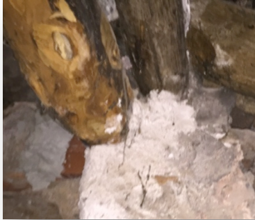
Dos vigas cumbreras
