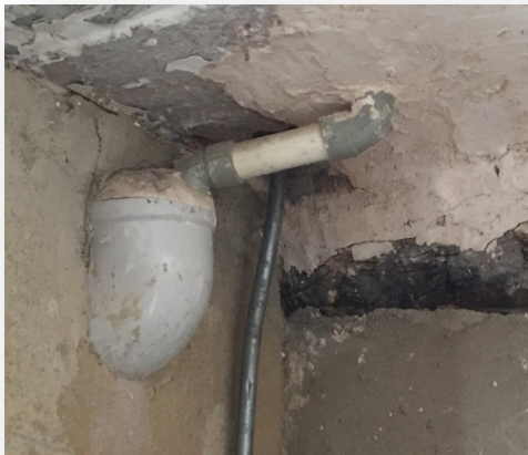
Instalación de fontanería y saneamiento
