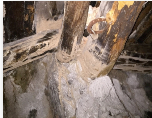
Encuentro vigas cumbreiras-pilar
