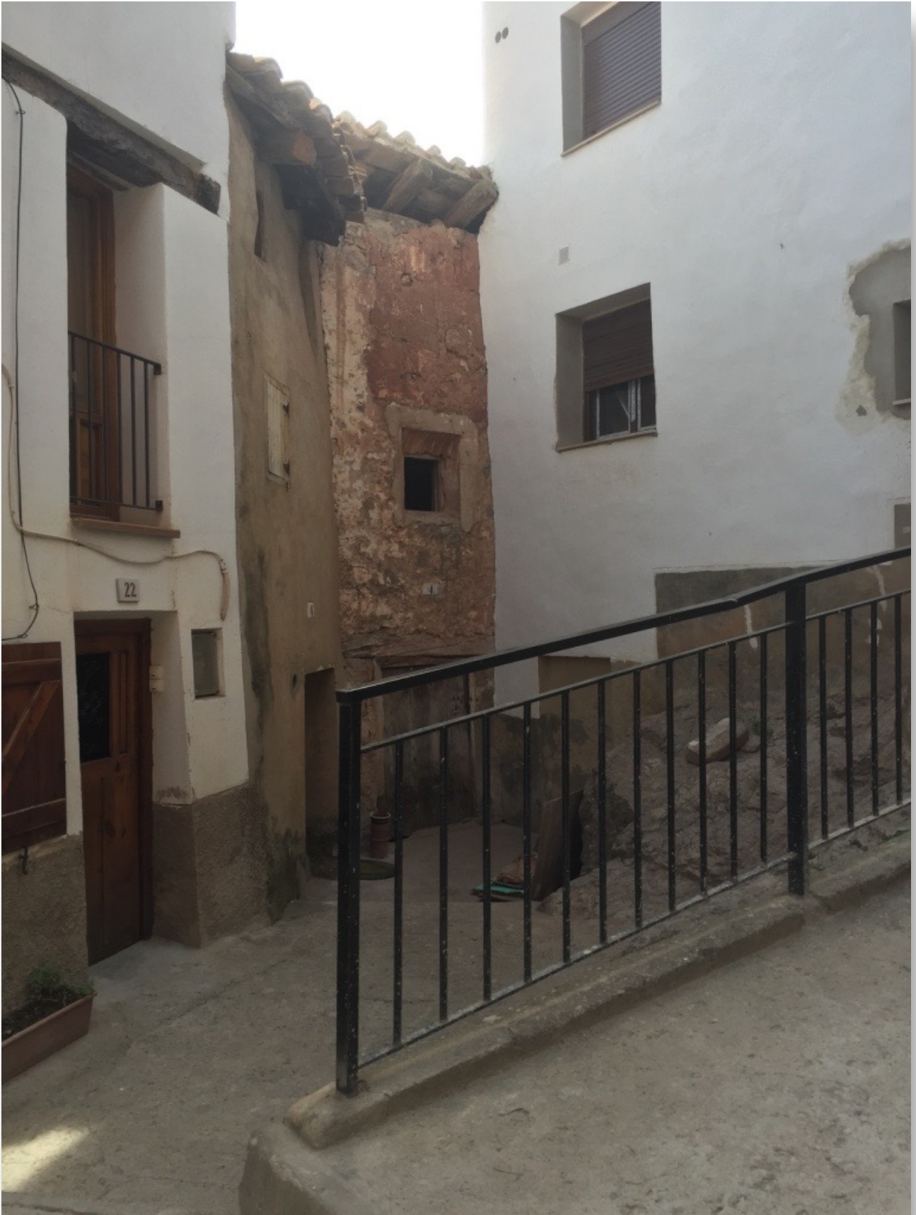
Vista de la vivienda desde la calle molino
