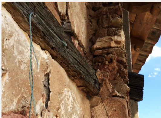
Viga transversal de fachada desde el exterior
