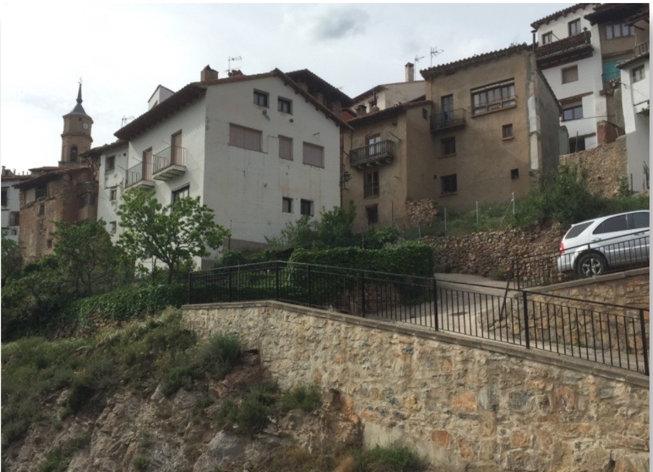
Vista del acceso a la calle de la vivienda
