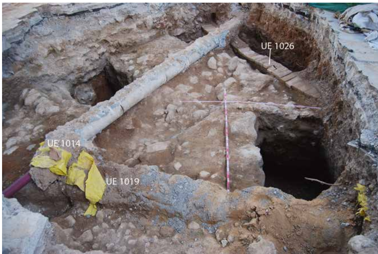
Figura 12. Algunas de las instalaciones de época reciente que cruzan el área de excavación.
