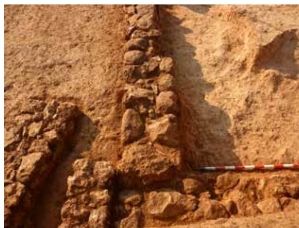
Figura 9. Mampostería empleada en la realización de los zócalos.
