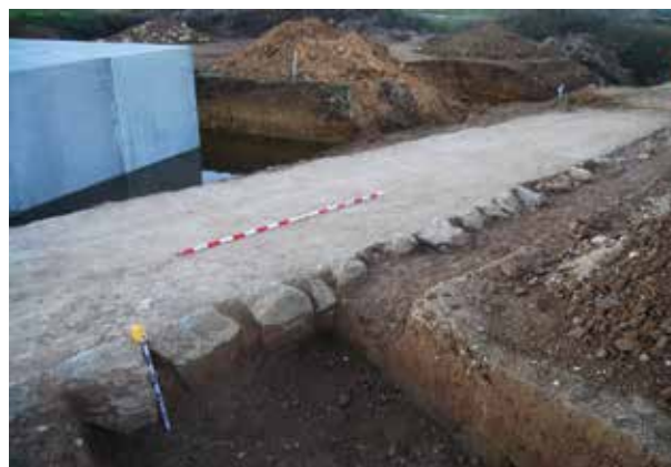
Figura 5. Vista de l'estructura lineal UE 1003 en el costat est de la via. Fotografia de R. Pérez Milián.
