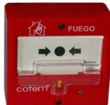
Figura 16, Sistema manual de alarma de incendios
