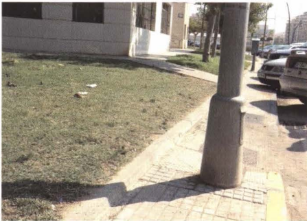
Farola mal col·locada
