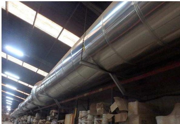
Figura 17. Conducto recuperación de calor de hornos
