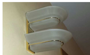
Imagen 122. Fluorescentes compactas de 15 W en escalera
