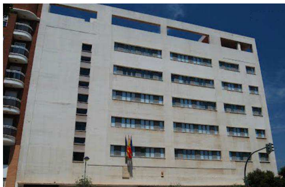
Imagen 52. Fachada principal de Nuevas Dependencias
