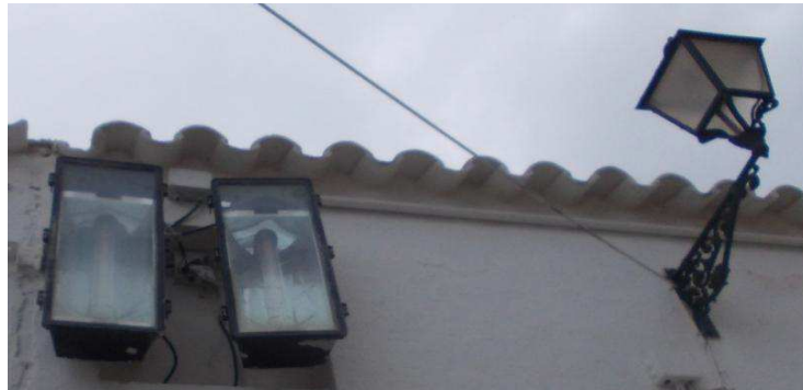
Imagen 102. Lámpara de Vapor de Sodio en proyectores y farolas exteriores
