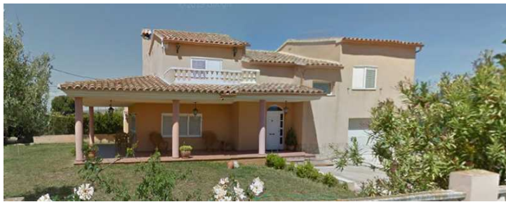
Imagen 114. Fachada principal de Villa Silvia
