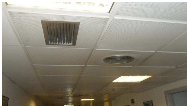
Imagen 58. Pantallas de tubos fluorescentes 4x18 W en 1ª, 2ª y 3ª planta
