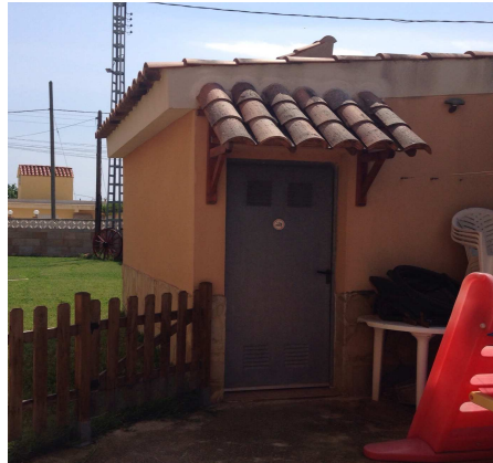
Imagen 133. Cuarto de caldera
