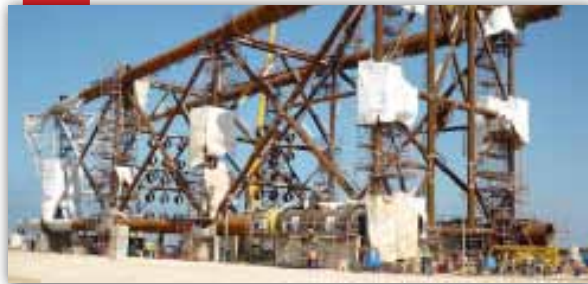
Castor: més de 100 persones treballen en les obres prèvies
