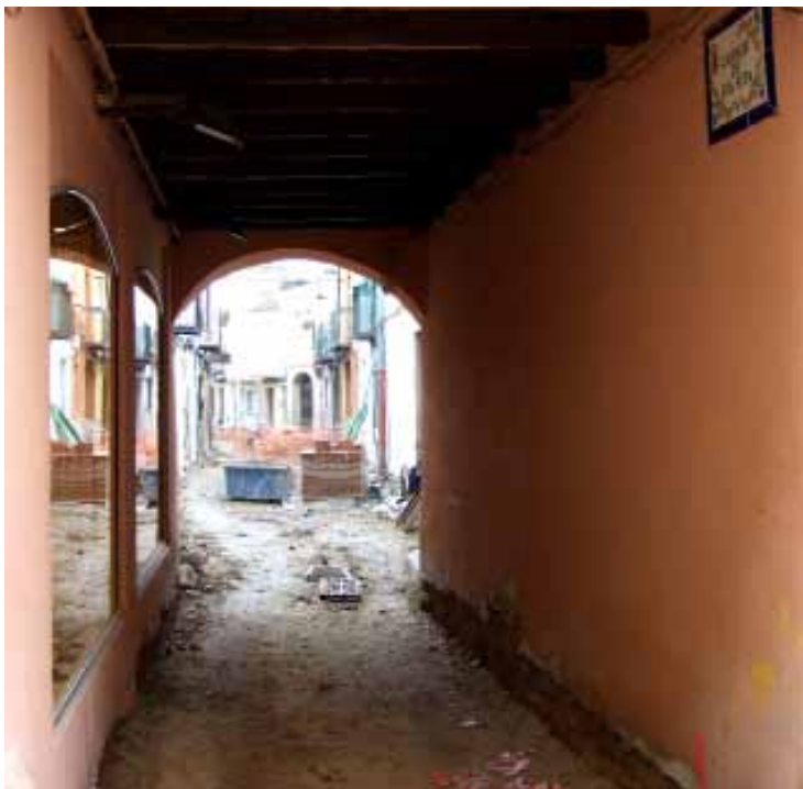
Las obras de la calle Santa Rita continúan a buen ritmo
