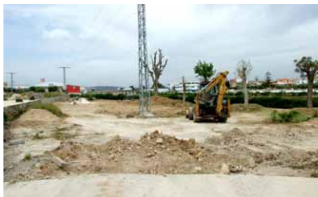
Les obres del parc per a gossos ja han començat
