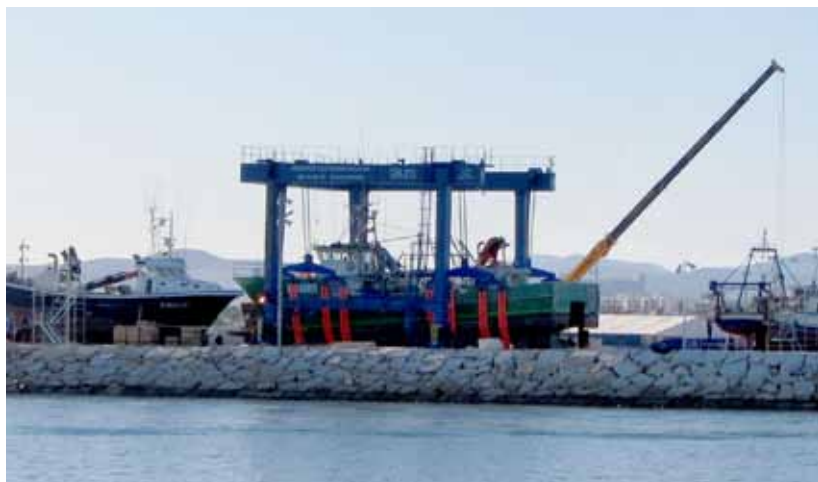
El nuevo travelling del puerto ha comenzado a operar
