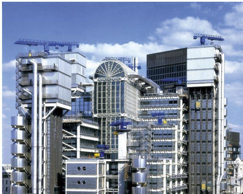
Edifici Lloyd's. Richard Rogers. Londres. 1979-1986
