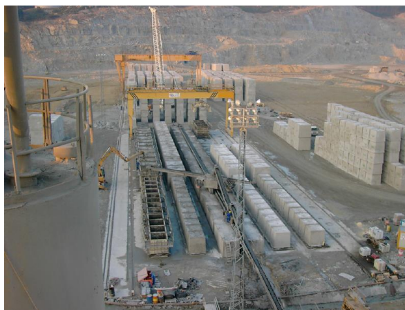
Figura 2-1. Fabricación de bloques de hormigón [22]
