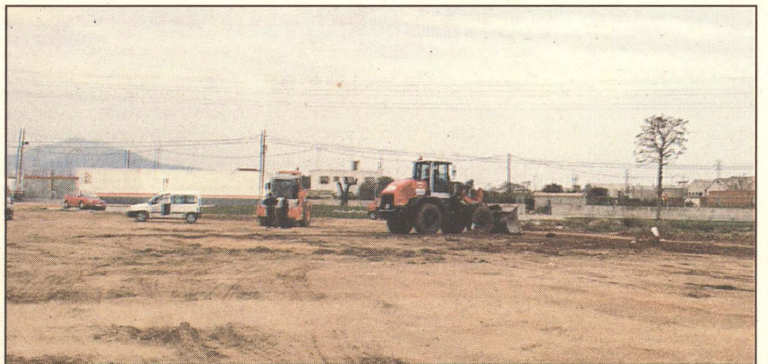
Comienzan las obras del futuro ecoparque
