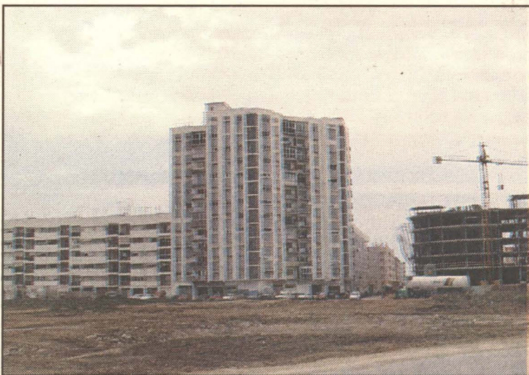
Demolición de edificaciones
