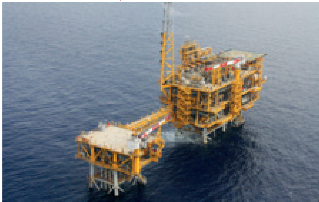
Vista de la planta marina, a 22 km de la costa de Vinaròs
