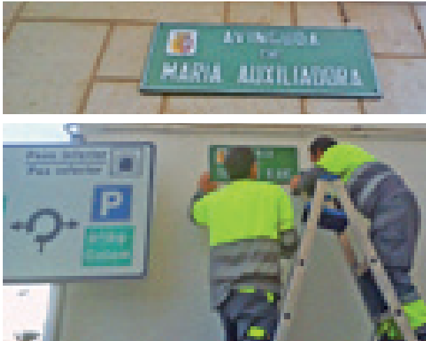
La brigada municipal ha iniciado los trabajos e instalará las 98 placas en las próximas semanas
