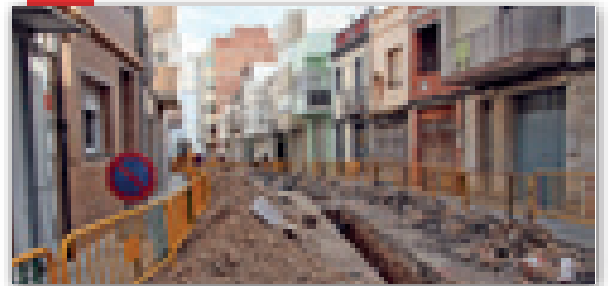
Obres al carrer de Sant Gregori
