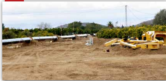
Comencen les obres del gasoducte terrestre del Castor
