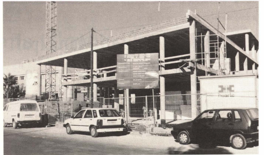
Estat actual de les obres.
