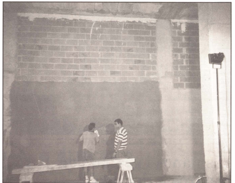
Avanzan las obras. Foto: A. Alcázar
