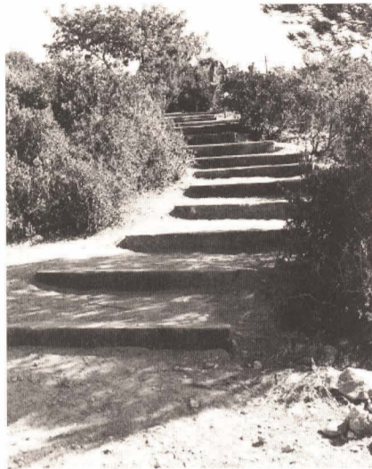
Camino recuperado y reconstruido con traviesas de madera de la antigua vía férrea
