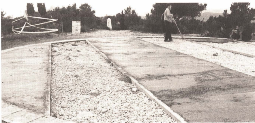
Trabajos de relleno y hormigonado de la cimentación de la era
