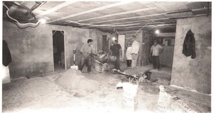
Obras de reforma en el nuevo local. Foto: Difo's
