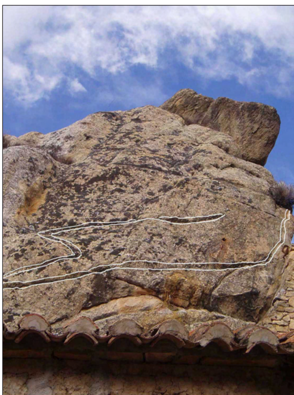
Figura 2. Canal de tejado: canales diseñados para desviar la precipitación que resbala por la roca, con el objetivo de proteger las construcciones apoyadas en ellas.
