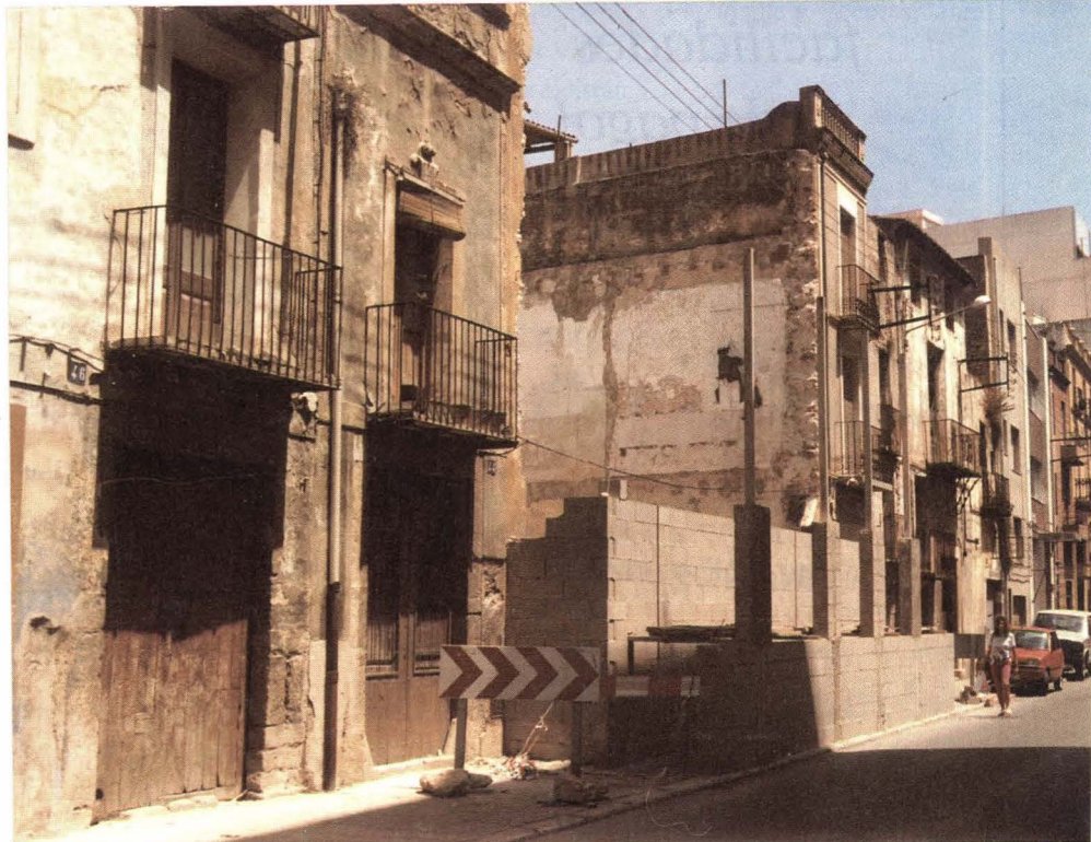
Han comenzado las obras del Hogar del Jubilado. Foto: Reula
