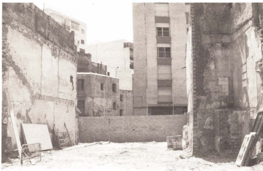
Han comenzado las obras del Hogar del Jubilado. Foto: Reula
