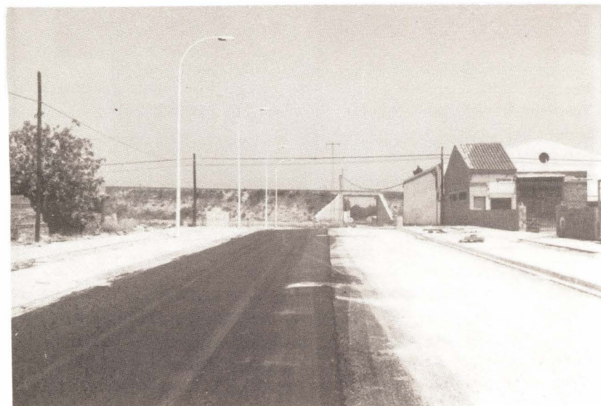
Casi a punto de finalizar las obras de la Avda. Gil de Atrocillo. Foto: Reula
