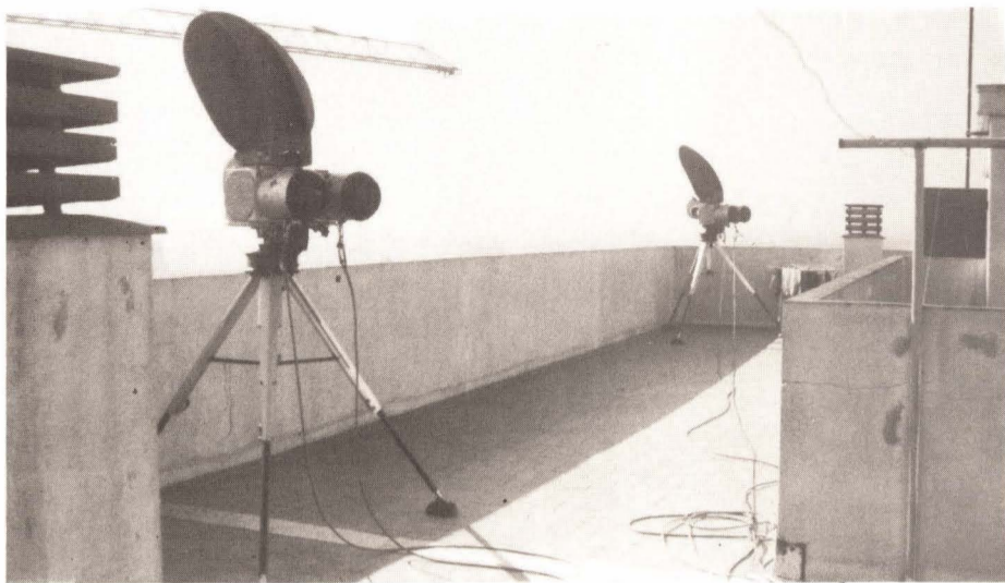
Antenas Edificio Arnau. Foto: Reula
