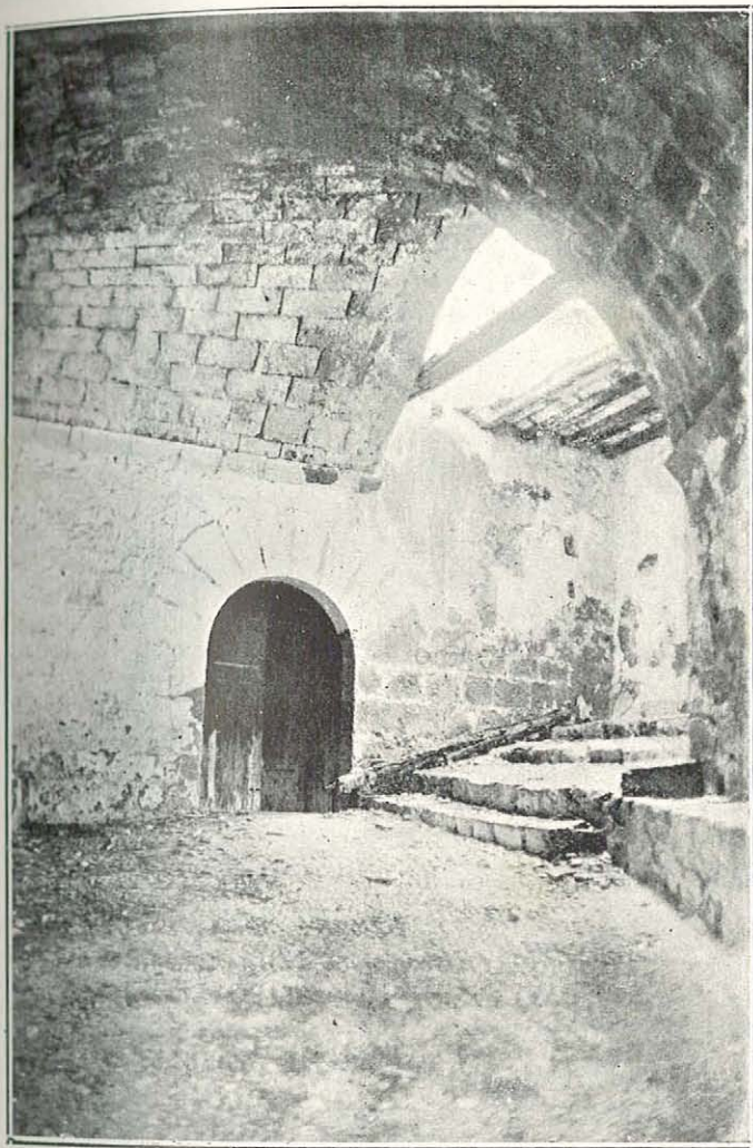
Patio de entrada del Castillo
