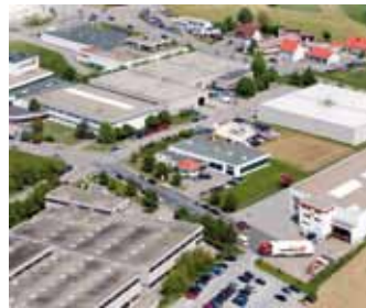
Planta de fabricación de motores y ventiladores de Rosenberg en Künzelsau, Alemania.
