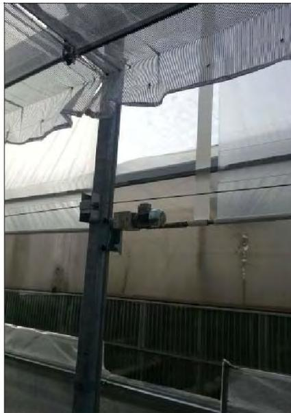
*Ventana enrollable de apertura con motor TRIFÁSICO de desplazamiento vertical*
