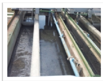
Ilustración 3. Desarenador/Desengrasador.
