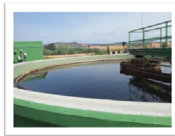
Ilustración 5. Decantador primario.
