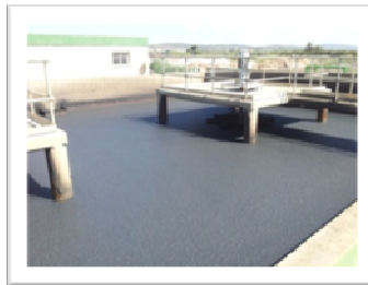
Ilustración 7. Digestión aerobia.
