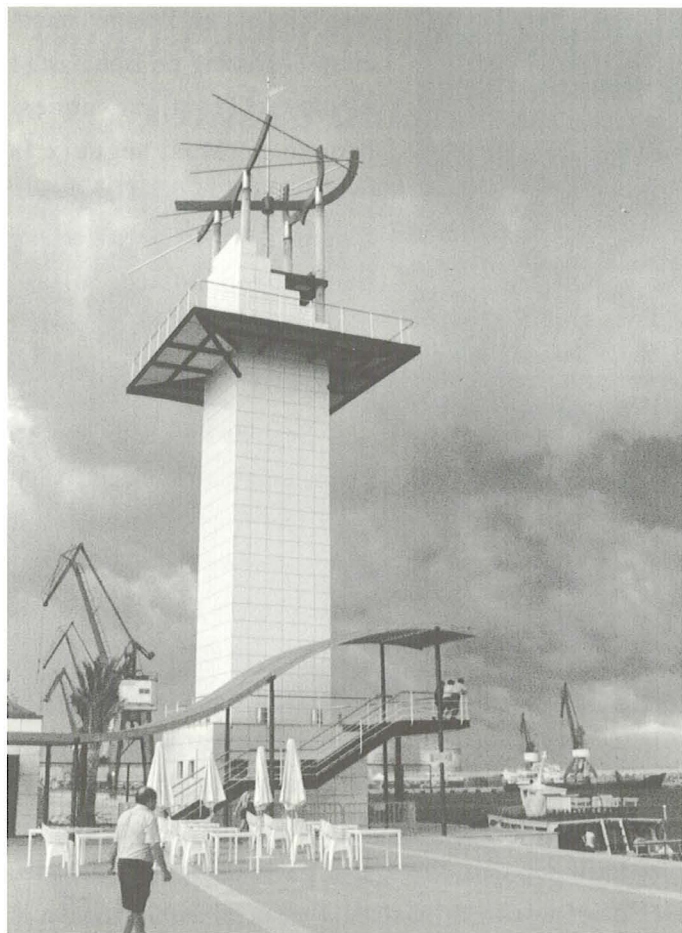
Una nau concavada curulla la torre, sembla que solca l'aire, cel endins. Enllà Foto: Arxiu J. Campos
