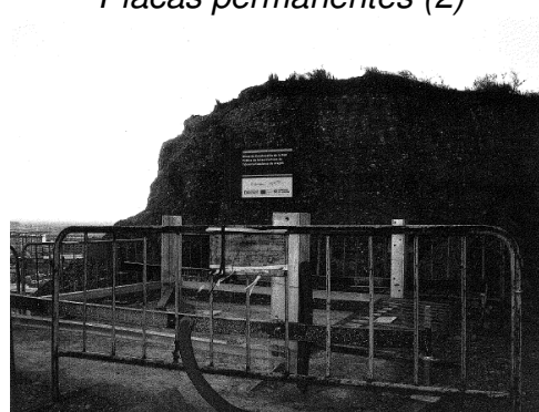
Cartelería informativa en obra
